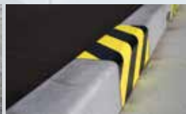
Trotoar/ Pembatas Jalan
